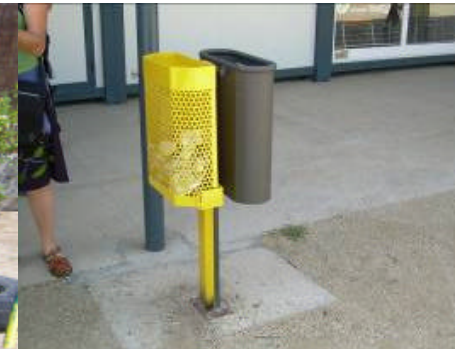
Instalación de papeleras de patio
