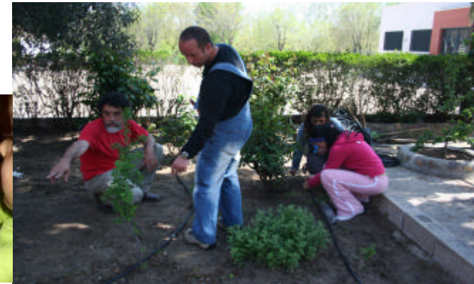
Instalación del riego por goteo en el jardín de la escuela
