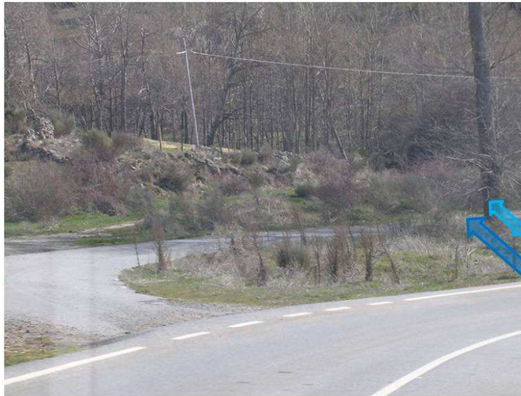
Figura 6. A veces tramos antiguos quedan adosados a las modificaciones más modernas, reduciendo el índice de apertura y la eficacia de las obras de drenaje transversal que podrían estar siendo empleadas por algunas especies, pese a la ausencia de cerramiento. Una correcta evaluación requiere manejar varias escalas de estudio en función de las especies potencialmente afectadas.
