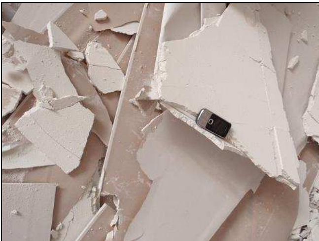
O Detalle del material de reciclaje "seco".
