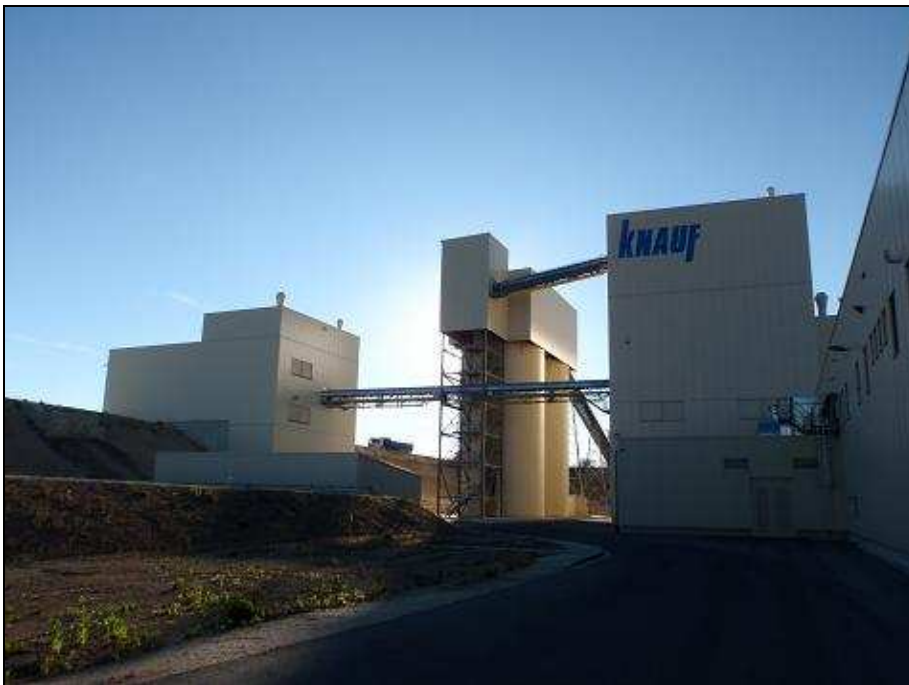
J Vista general de la planta de reciclaje de la fábrica de Knauf GmbH en Escúzar (Granada)
